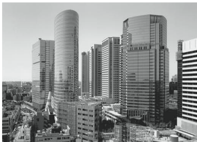
図5 品川駅東口の開発状況
