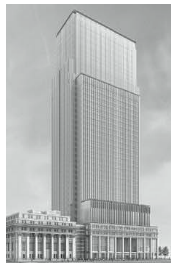
図7 歴史的建造物の保存を含めた特定街区を適用して整備された日本橋三井タワー（東京都中央区）
